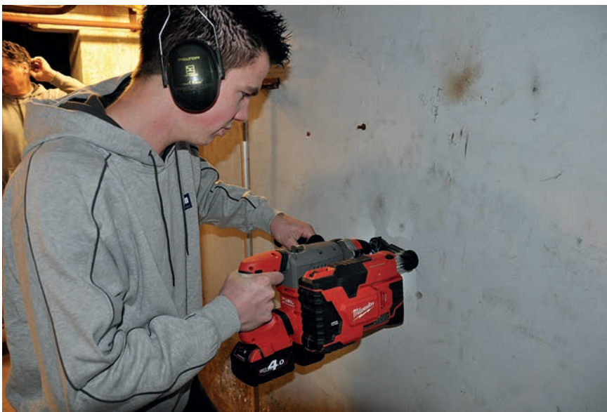
Boren met afzuighulpstuk.
