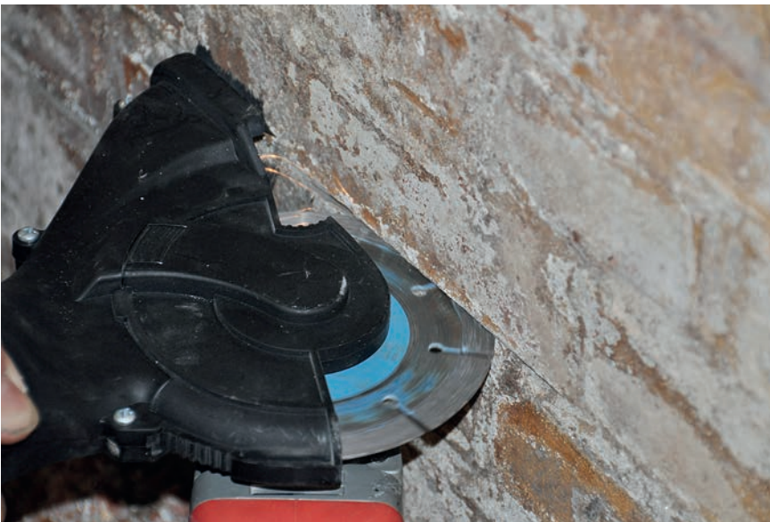
Slijpen met afzuiging: volg de vonken.
