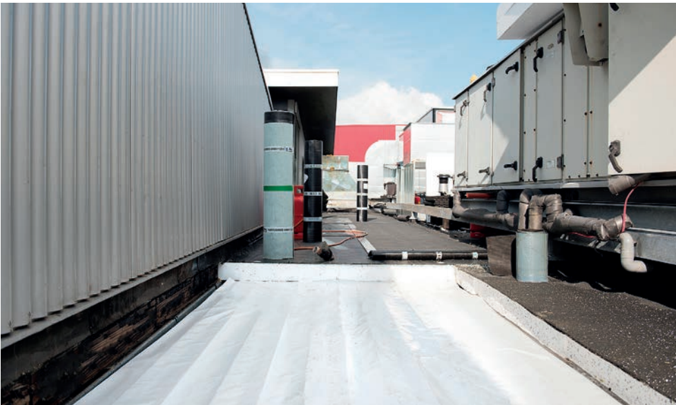
Opbouw van de nieuwe dakbedekkingsconstructie met op de voorgrond de zelfklevende dampremmende laag.
