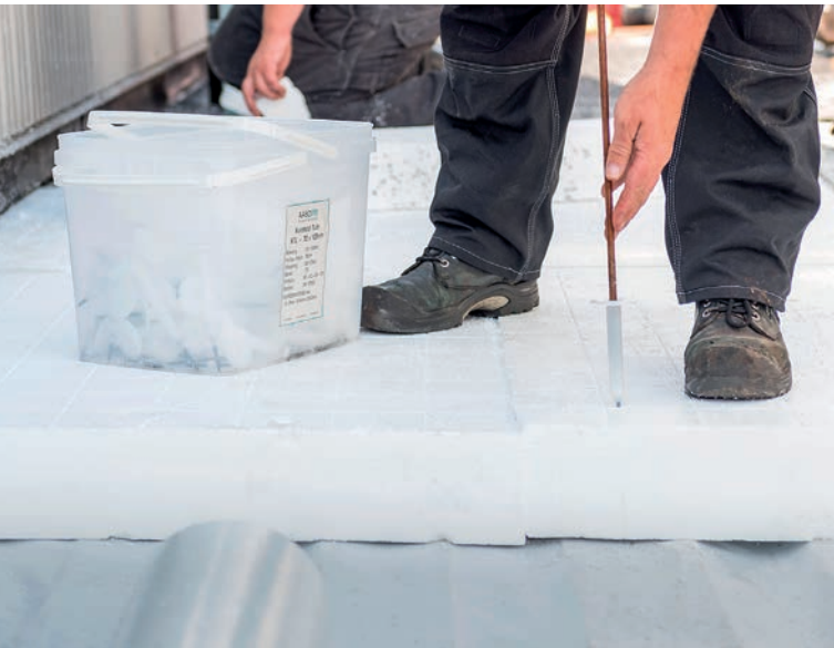
De Airpop® isolatie wordt met zogenoemde werkparkers bevestigd.
