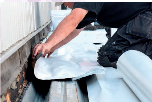
Aansluiting dampremmende laag bij gevel.
